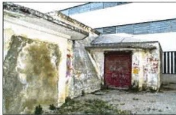
Una de las puertas de acceso al refugio
