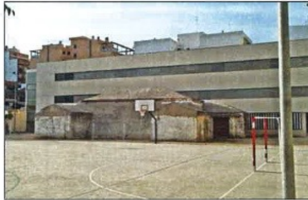
Vista actual del refugio dentro de la zona deportiva del centro escolar El Grao
