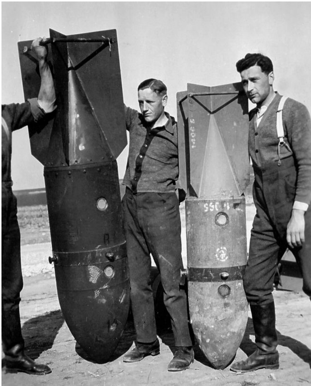
Bombas de fabricación alemana SC-500 y SC-250
