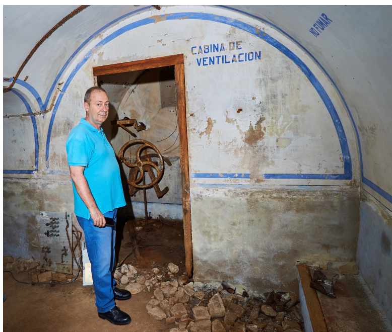
Cabina de ventilación del refugio del Grupo Escolar Balmes.
