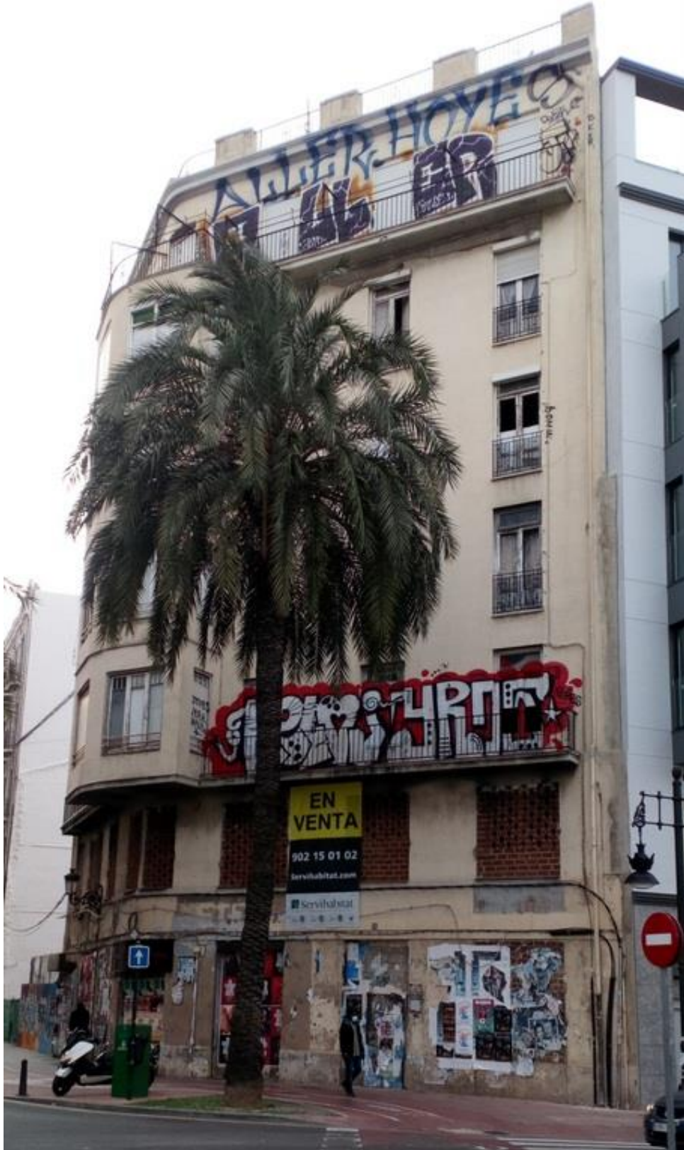
Fig. 38– Edifici situat al número 53 del carrer Gran Via Germanies de València (2020).
