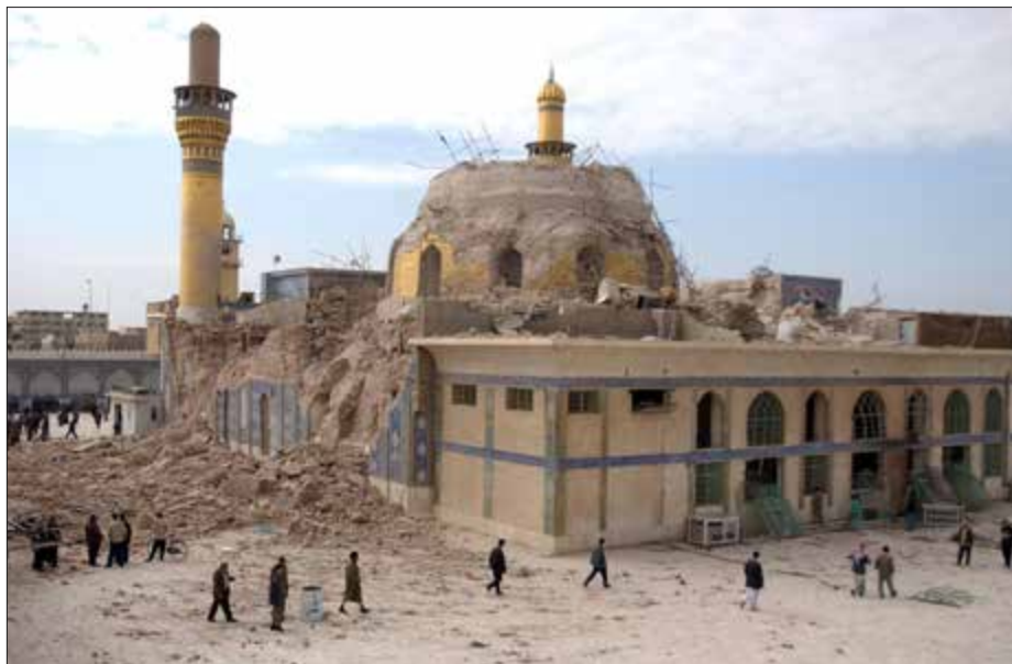
Fig. 2. Los graves daños causados al Santuario de al-Askari en Samarra, Iraq, han sido considerados por muchos como el punto de inflexión que convirtió el malestar general ante la presencia de la Coalición en Iraq en una guerra civil a gran escala y sectaria. Foto: © Ejército de los EE. UU., vía Wikimedia Commons.
