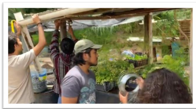
(Construcción del sistema de recolección de agua pluvial)
