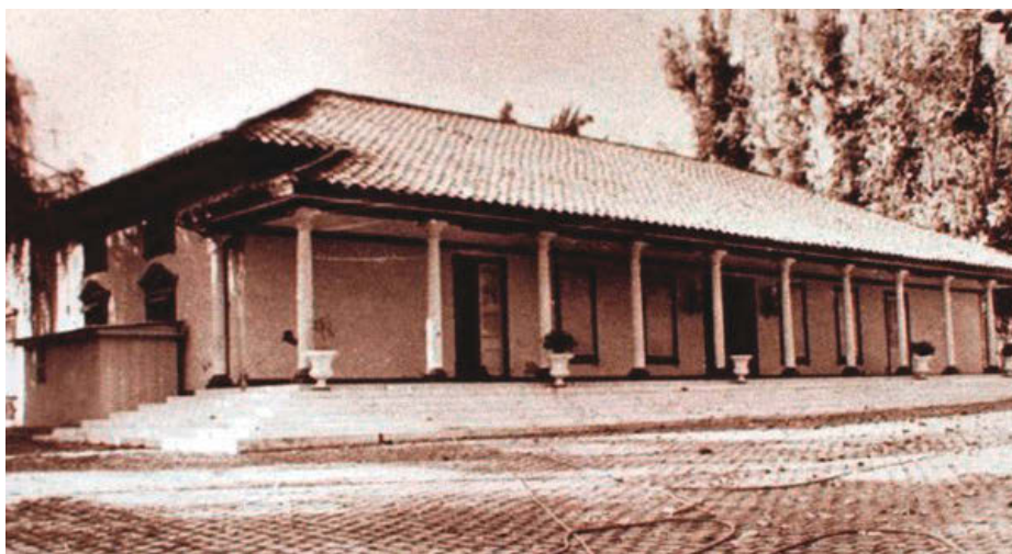
Fig. 1. Villa Grimaldi antes de 1973. Fuente: Archivo Documental de la Corporación Parque por la Paz Villa Grimaldi.
