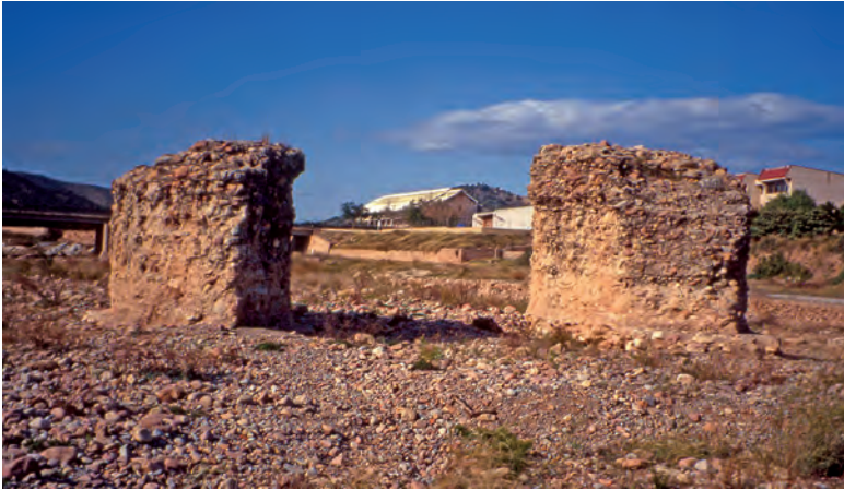
Fig. 6.- Els Pilons, estreps del pont de Sagunt sobre el riu Palància (Foto: autor).
