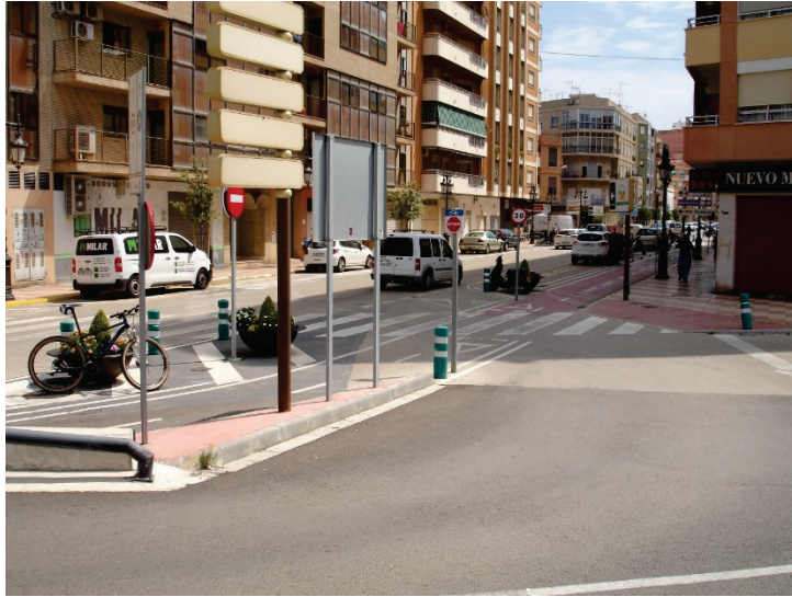
Imagen 20. Cruce del Pont de Pedra con el carril bici para acceder a la Diagonal.
