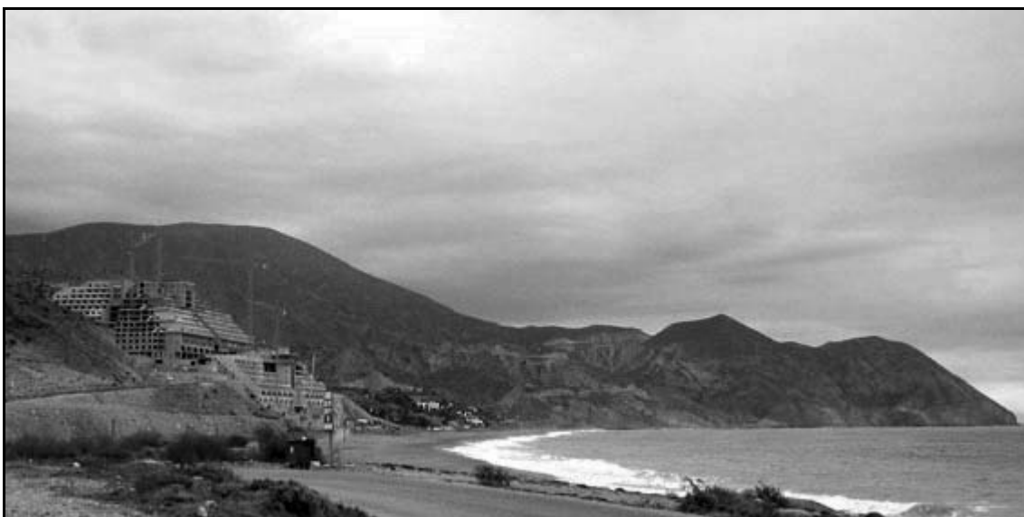
Figura 98: Construcció de l'hotel a l'Algarrobico en 2005 en el bell mig del parc natural. Fotografia. Asociación de Amigos del Parque Natural del Cabo de Gata-Níjar.
