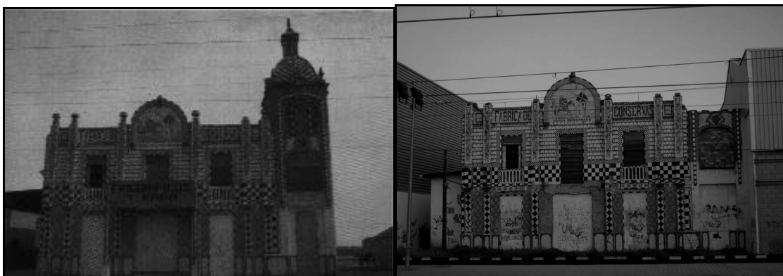
Figura 59: Fàbrica de conserves d'estil modernista a Catarroja. Ja en 1981 era un edifici abandonat i deteriorat. En 25 anys s'ha deixat caure literalment i està en greu perill d'enfonsament. Li falta la torre i ha quedat enquistat entre dues naus industrials al costat de l'estació de RENFE d'aquesta localitat. Fotografies: VILA (dir.), 1981 i Luis del Romero.
