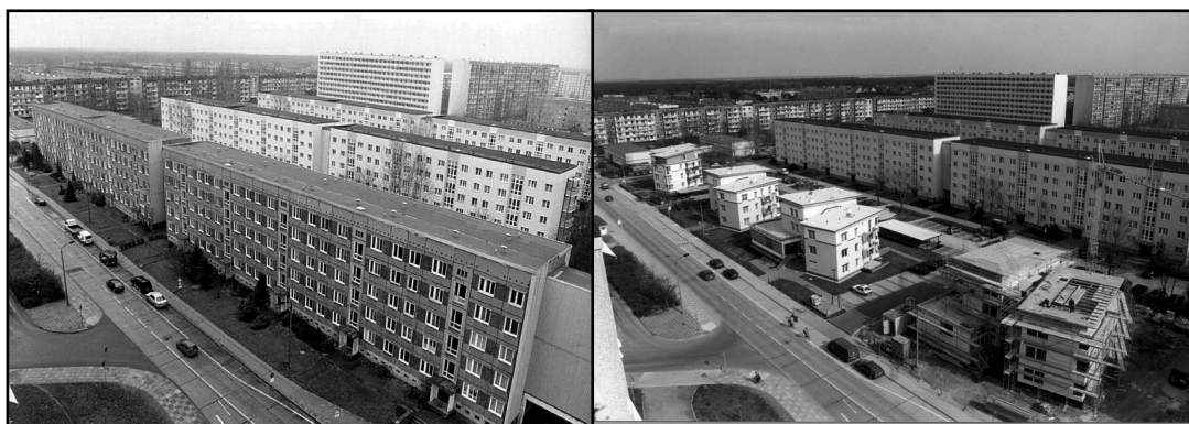
Figura 65: Rehabilitació d'un polígon d'habitatges a Hoyerswerda (Alemanya). Font: LebensRäume Hoyerswerda eG.
