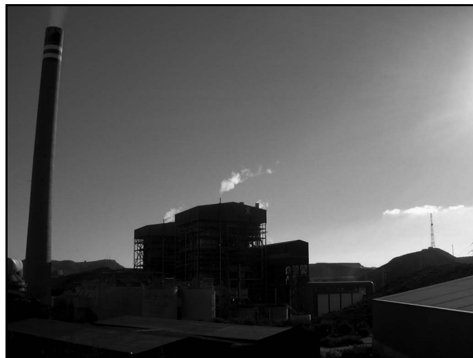
Figura 83: Planta tèrmica junt a la dessalinitzadora de Carboneras. Fotografia: Luis del Romero.
