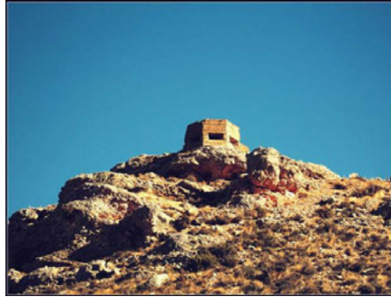
FIGURA 48 Fortín-nido de ametralladoras de las trincheras de Cabezo Santo (Monforte de Moyuela)
