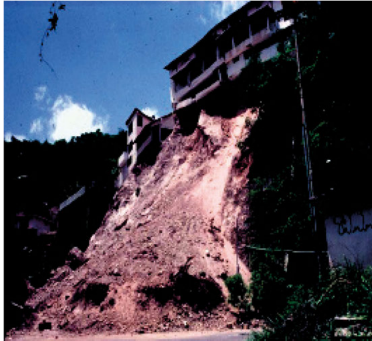
Figura: Erosión y deslizamiento de terreno. Fuente: Google
