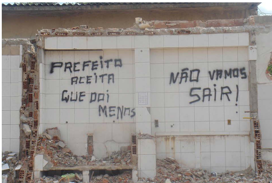
Fig. 3. Demoliciones. Recado para el alcalde en los escombros. Autor: Luiz Claudio da Silva. Archivo del Museu das Remoções.
