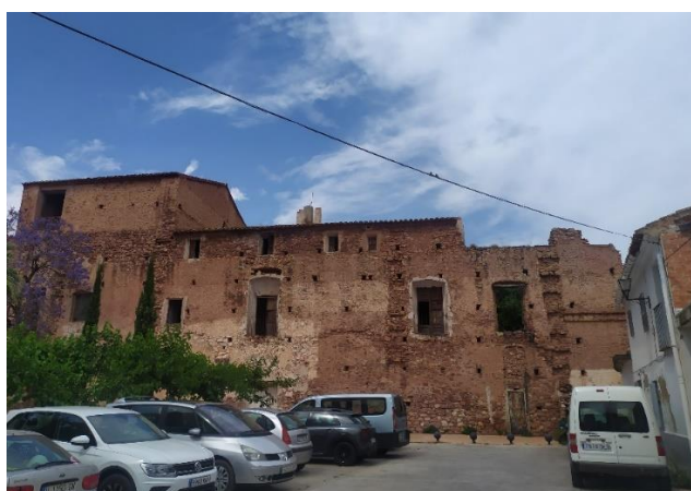
Fig. 82. Estado de conservación actual del palacio Vives de Banyamàs en Benifairó de les Valls (València), Andrea Lurago y otros, comienzos del siglo XVII. Vista de la torre noroeste y de su crujía adjunta desde el sur.
