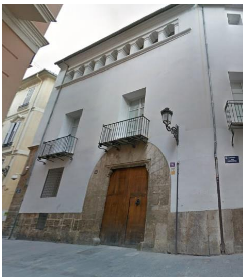
Fig. 73. Fachada principal de la casa de los Julià. Calle Cadirers nº 14, València.
