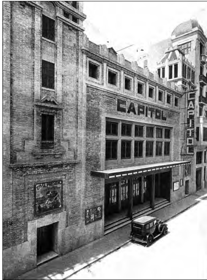
Fig. 1.- Joaquín Rieta Sister. Fachada del antiguo Cine Capitol, 1933. (Fotografía: Joaquín Rieta Sister [TEJEDOR, 2013, p. 82])
