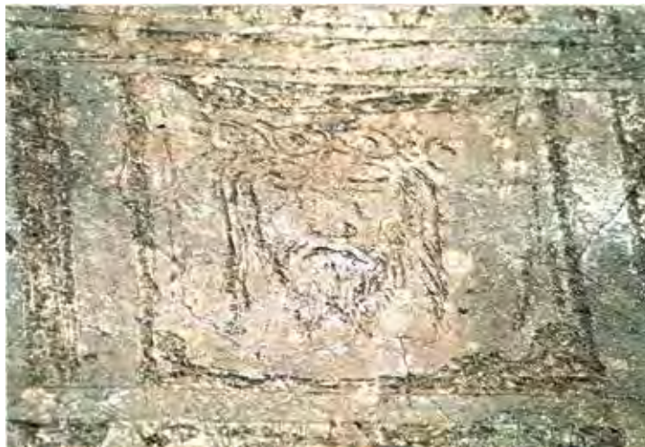
Fig. 6.- y 7.- Visión parcial y detalle del esgrafiado de la farmacia-portería. © C. Bauçà de Mirabò.
