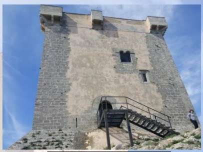
Façana nord-est, amb l'entrada. Fachada noreste, con la entrada.
