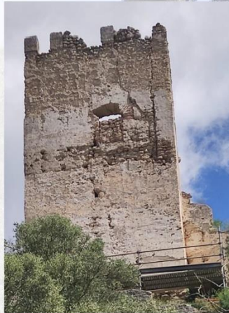
"Torre de l'Homenatge o de les Traces". "Torre del Homenaje o de las Trazas".
