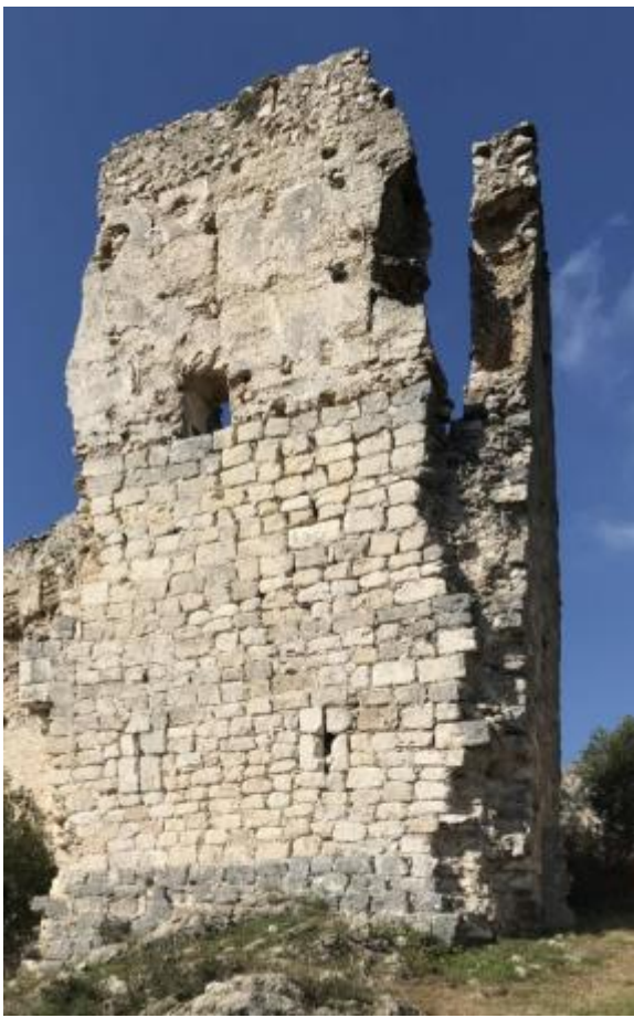
“Torre dels encoixinats”. Extret de: Vidal Mallén, J. (2020): El levantamiento fotogramétrico del patrimonio arquitectónico construido como herramienta de análisis y conocimiento: El caso del Castell de la Vall de Perputxent . Alicante: Universidad de Alicante, Escuela Politécnica Superior. [Trabajo de Final de Grado].
