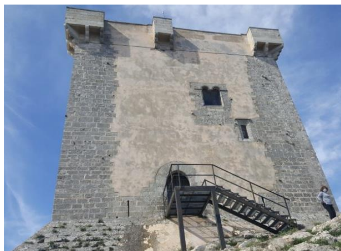
Façana nord-est, amb l'entrada. Producció pròpia (fotografia presa el 15-5-2021).
