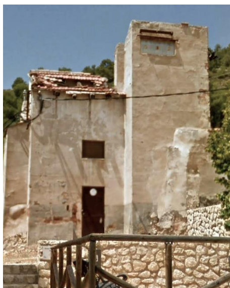
Vista general de la torre. Extret de: < https://links.uv.es/OmZkR5T > [consulta: 09-07-2022].
