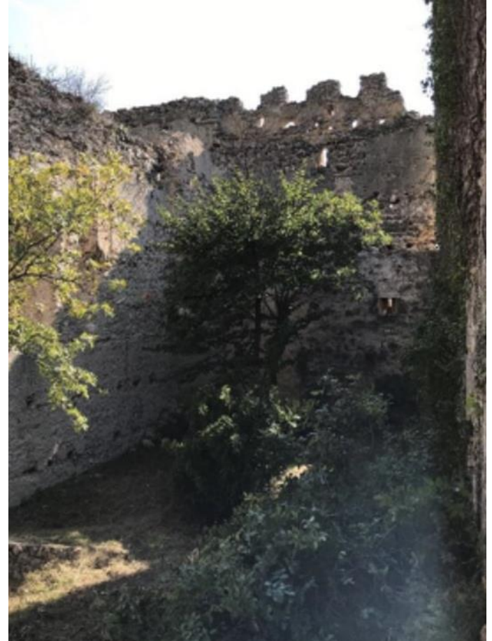
Interior de l’edifici palatí. Extret de: Vidal Mallén, J. (2020): El levantamiento fotogramétrico del patrimonio arquitectónico construido como herramienta de análisis y conocimiento: El caso del Castell de la Vall de Perputxent . Alicante: Universidad de Alicante, Escuela Politécnica Superior. [Trabajo de Final de Grado].
