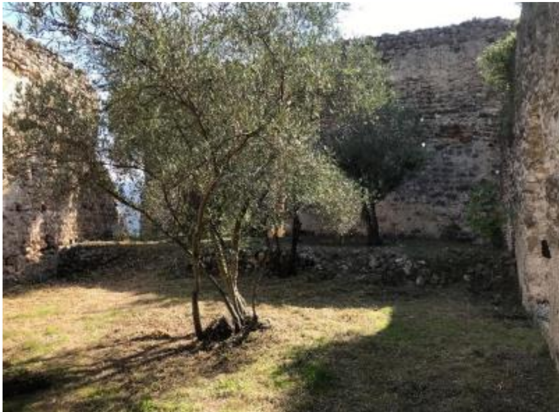
Pati d'armes. Extret de: Vidal Mallén, J. (2020): El levantamiento fotogramétrico del patrimonio arquitectónico construido como herramienta de análisis y conocimiento: El caso del Castell de la Vall de Perputxent . Alicante: Universidad de Alicante, Escuela Politécnica Superior. [Trabajo de Final de Grado].
