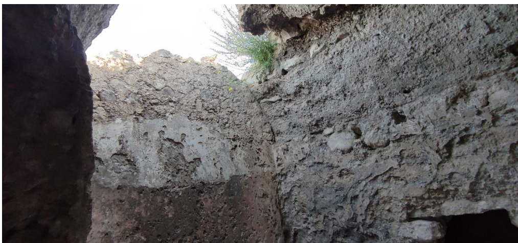
Interior del primer aljub. Producció pròpia (fotografia presa el 22-5-2021).
