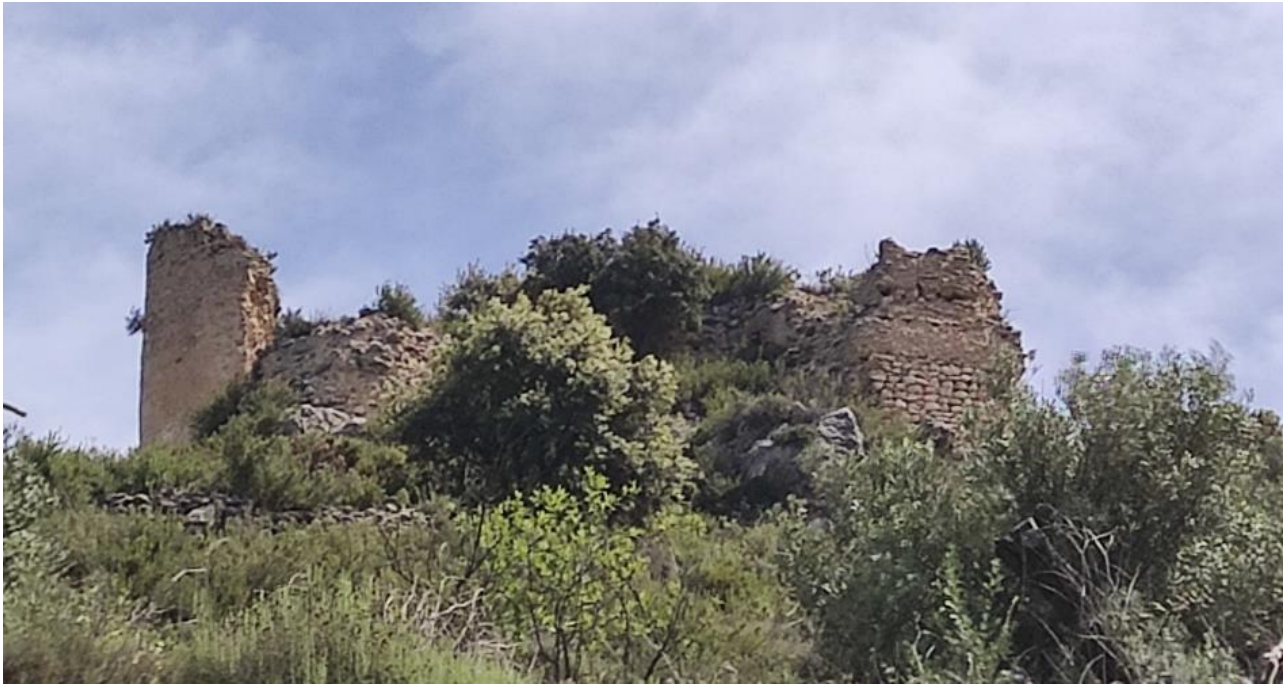
Vista general de la part sud-oest del castell. Producció pròpia (fotografia realitzada el 22-5-2021).
