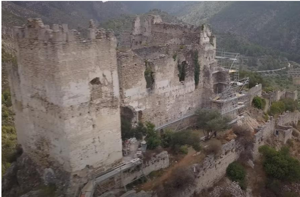
Tota l'àrea cristiana del castell, amb les torres i àrea palatina en la qual s'aprecien els andamis i passarel·les que estan emprant-se en els treballs de consolidació. Extret de: < https://www.youtube.com/watch?v=glmRbCxFLMY > [consulta: 15/04/2021].
