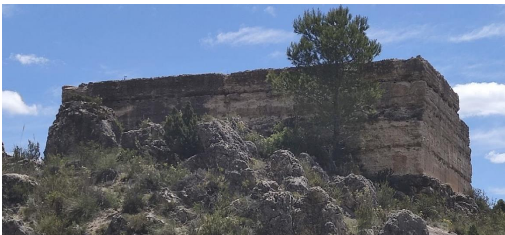
Cara nord del castell. Producció pròpia (fotografia presa el 14-05-2021).
