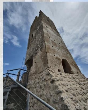
Torre de l'Homatge. Torre del Homenaje.
