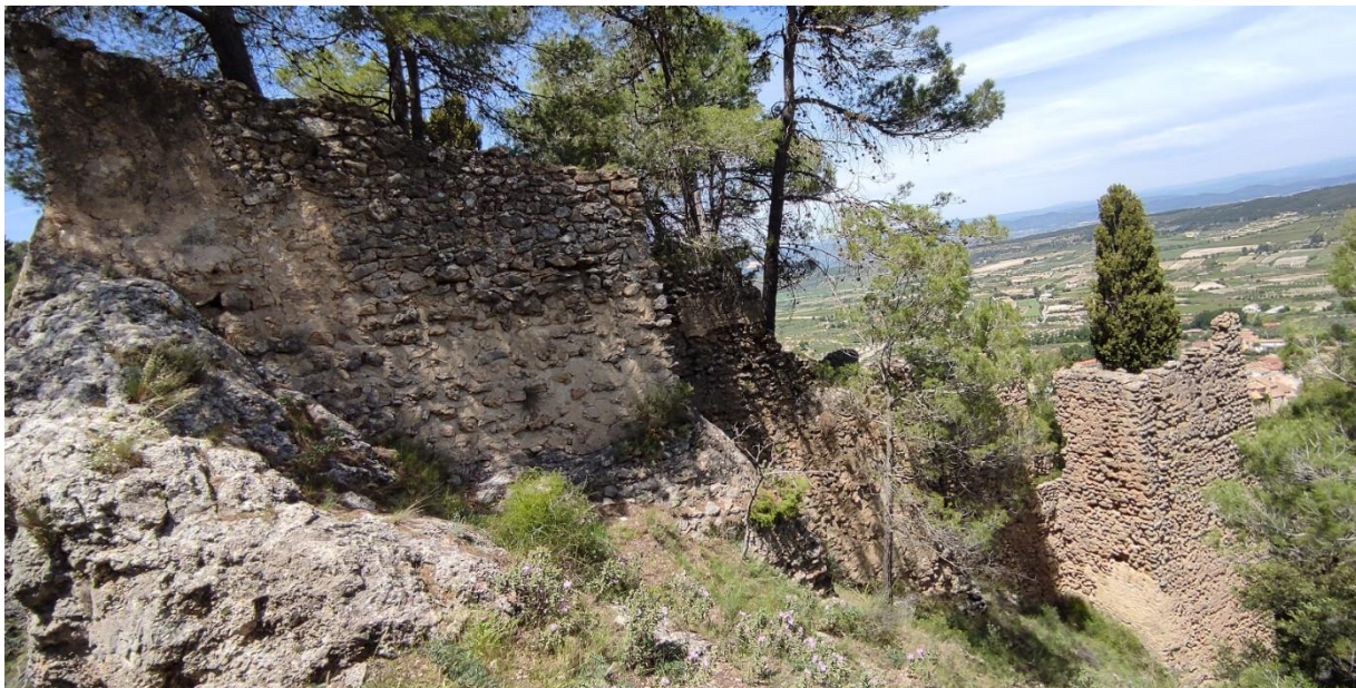
Parament est del castell. Producció Pròpia (fotografia realitzada el 15-5-2021).
