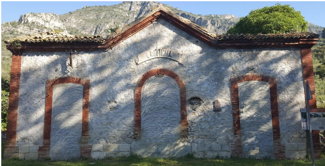
Façana principal de l'antiga estació. Producció pròpia (fotografia presa el 07-5-2021).
