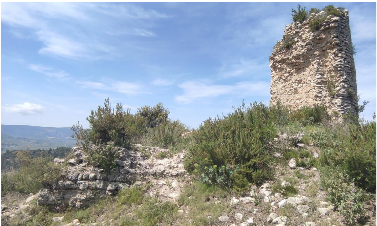
Interior del castell, amb restes d'estructures d'habitatge i del perímetre mural musulmà i la torre cristiana nord-oest. Producció pròpia (fotografia realitzada el 22-5-2021).
