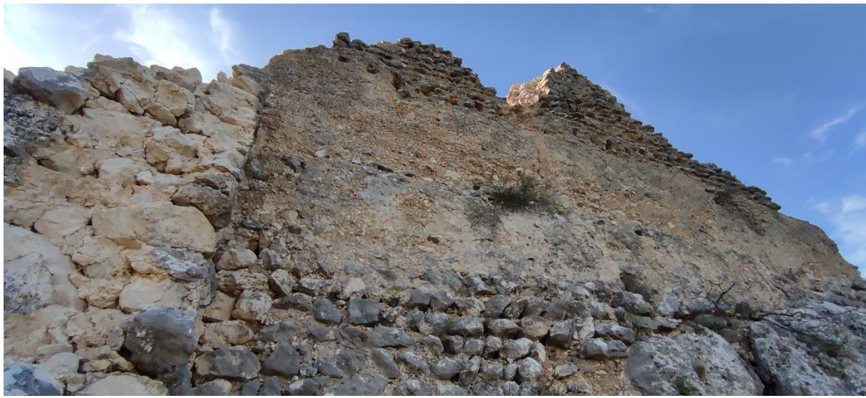
Paret nord de l'edifici principal. Producció pròpia (fotografia presa el 22-5-2021).
