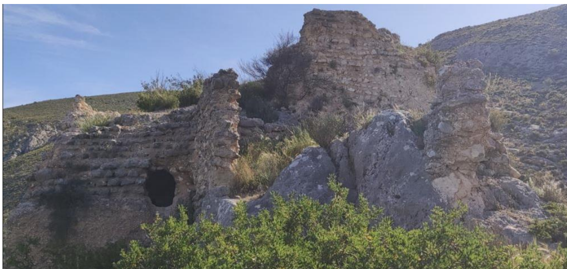
Vista general de l'estructura principal del castell. S'aprecia l'entrada als aljubs Producció pròpia (fotografia presa el 22-5-2021).
