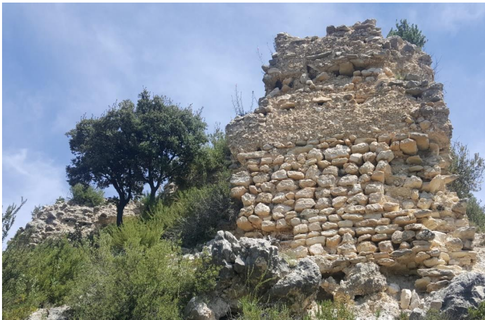
Detall d'una torre d'època musulmana de la part sud-oest. Producció pròpia (fotografia realitzada el 22-5-2021).
