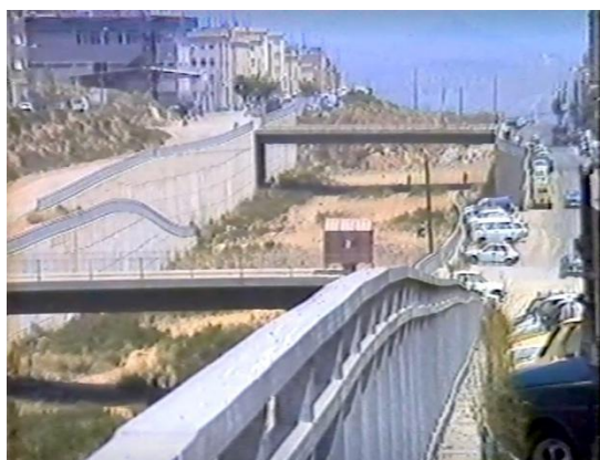
Fig. 2. Las obras paralizadas de la Ronda de Dalt (min. 0:00:43)
