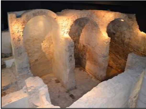
Figura 123. Baños de Lliria . Siglo XII. Lliria (Valencia). Disposición de las tres salas húmedas. Se puede apreciar el grosor de los muros que separan las distintas dependencias. Araceli Moreno Coll, 2016.
