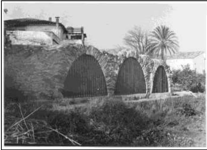
Figura 131. Baño de Torres-Torres. Torre-Torres (Valencia). Siglo XIV. Mario Guillamón Vidal (F153-029), 1958-1981. Biblioteca Valenciana Nicolau Primitiu (València) ©.
