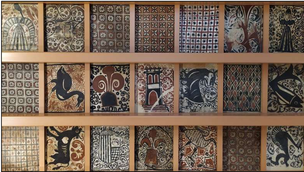
Figura 414. Reconstrucción de un fragmento de techo de una estancia del siglo XV, ofreciendo la manera cómo se colocaban los «socarrats» en las entrecalles de aquel. Museo Nacional de la Cerámica y Artes Suntuarias González Martí (València). Araceli Moreno Coll, 2021
