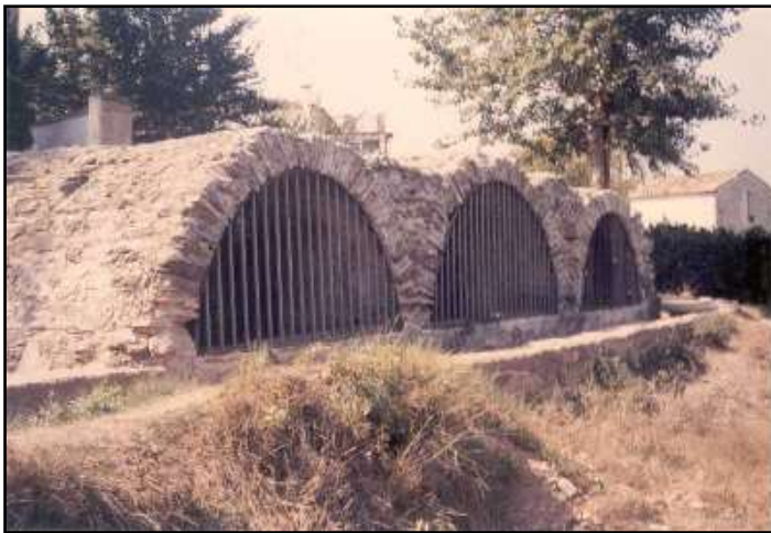
Figura 136. Baños de Torres-Torres. Siglo XIV. Torres-Torres (Valencia). Vista norte antes de la restauración. Carles Dolç Soriano, 1990.
