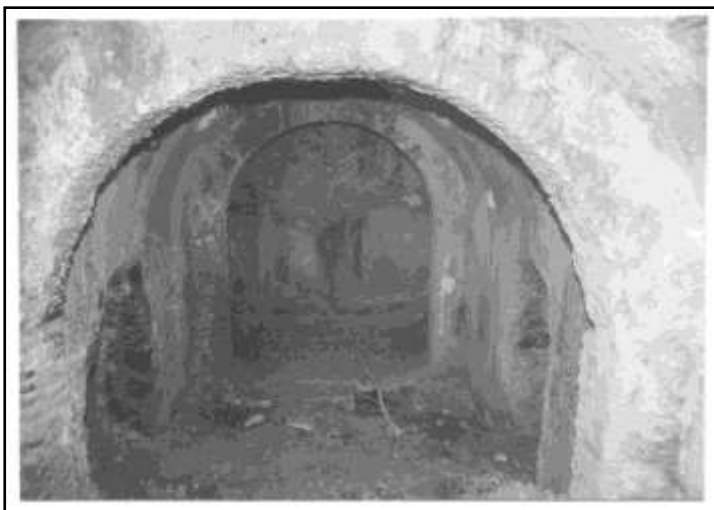
Figura 133. Baño de Torres-Torres. Torre-Torres (Valencia). Siglo XIV. Mario Guillamón Vidal (F153-033), 1958-1981. Biblioteca Valenciana Nicolau Primitiu (València) ©.
