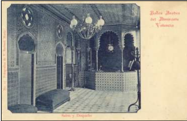
Figura 149. Baños del Almirante. Siglo XIV. València. Postal fotográfica. Salón y despacho.
