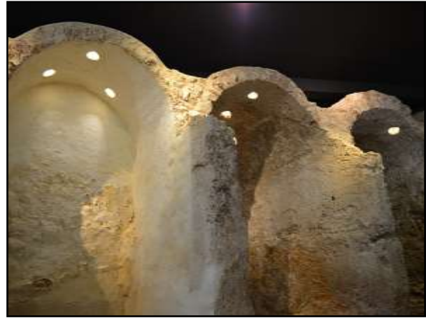
Figura 123. Baños de Lliria . Siglo XII. Lliria (Valencia). Disposición de las tres salas húmedas. Se puede apreciar el grosor de los muros que separan las distintas dependencias. Araceli Moreno Coll, 2016.
