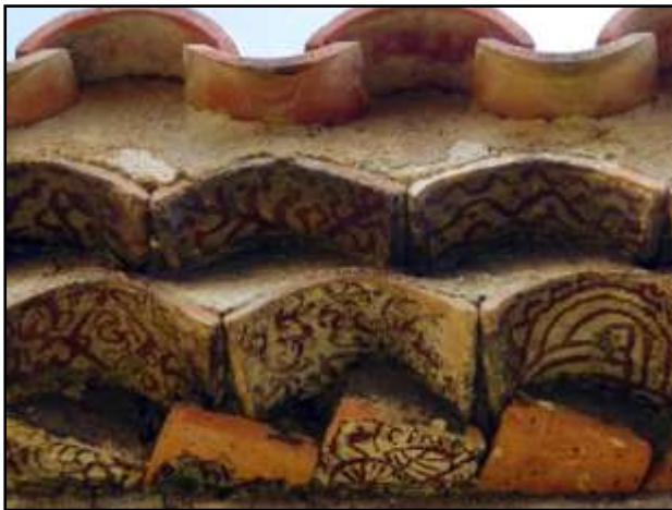
Figura 83. Disposición tejas y socarrats en el alero de la ermita de san Miguel de la Pobla de Bellestar. Villafranca del Cid (Castellón).
