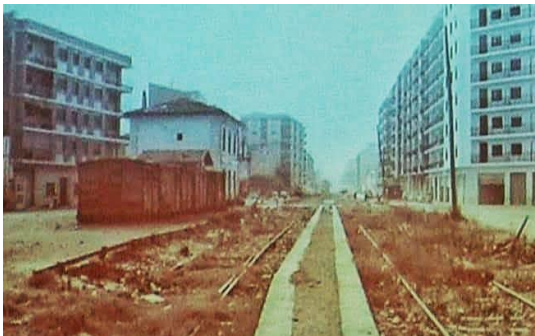
Vías del tren a su paso por la avenida Gregorio Gea
