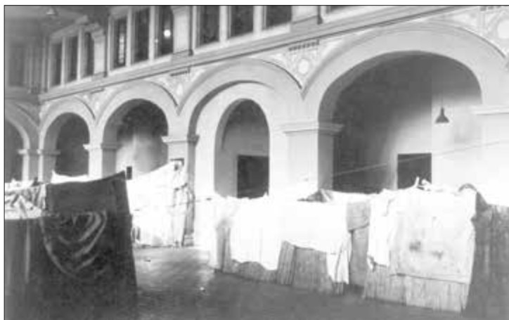
Interior de l'Estadi Olímpic, Barcelona, 1959. Foto: Joaquim Montserrat
