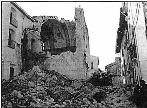
Estado en que quedó la torre de San Agustín. JOSÉ ALEXANDRE
