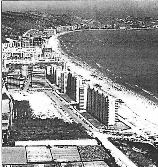
Las dos «pantallas» de Cullera. Tres más están por construir.
