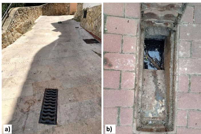
Figura 36. Situación y estructura típica de los imbornales muestreados en el término municipal de Les Coves de Vinromà. a) Puntos de muestreo CdV4 y CdV7. b) Punto de muestreo CdV9.
