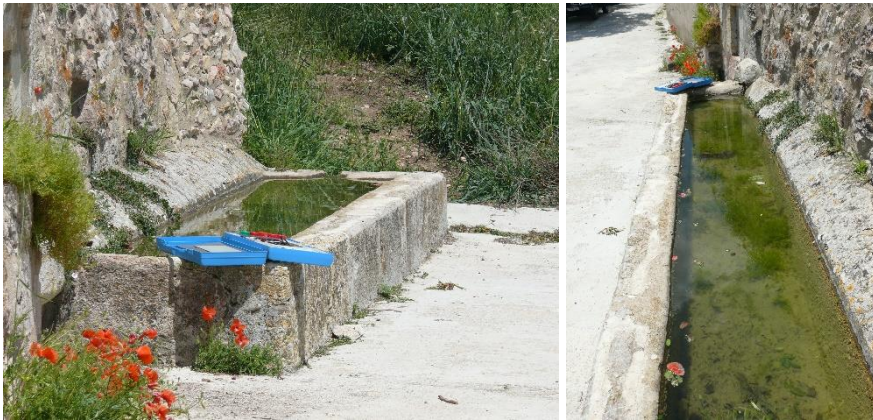
Figura 62. Abrevadero localizado en el núcleo urbano del término municipal de Castell de Cabres, correspondiente con el punto de muestreo CdC1.
