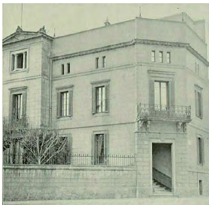
Fig. 6. Casa propia de Rafael Guastavino Moreno en la confluencia de las calles Aragón y Lauria de Barcelona, donde el arquitecto aplicó sus ideas a modo de ensayo en propias carnes (Wight 1901a).
