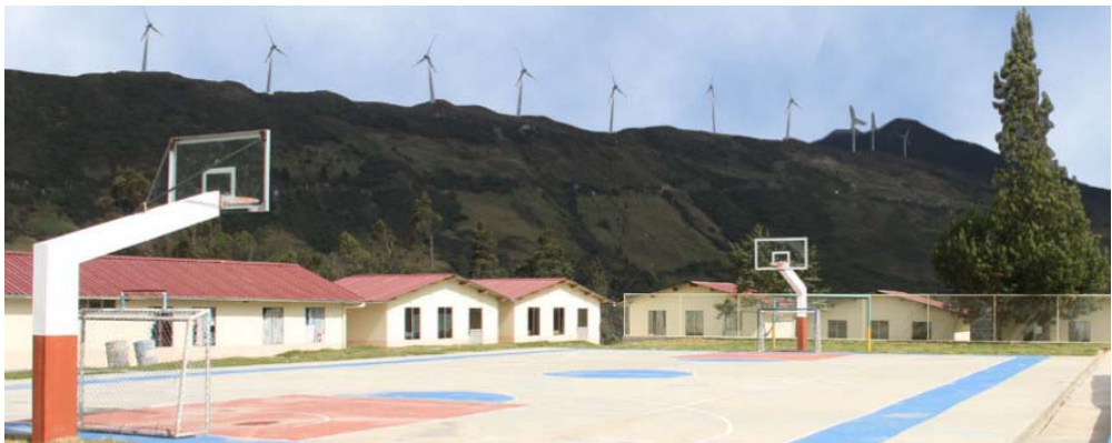
Figura 4. Escuela Municipal Tierras Coloradas, tras las obras de mejora (Loja, Ecuador).
