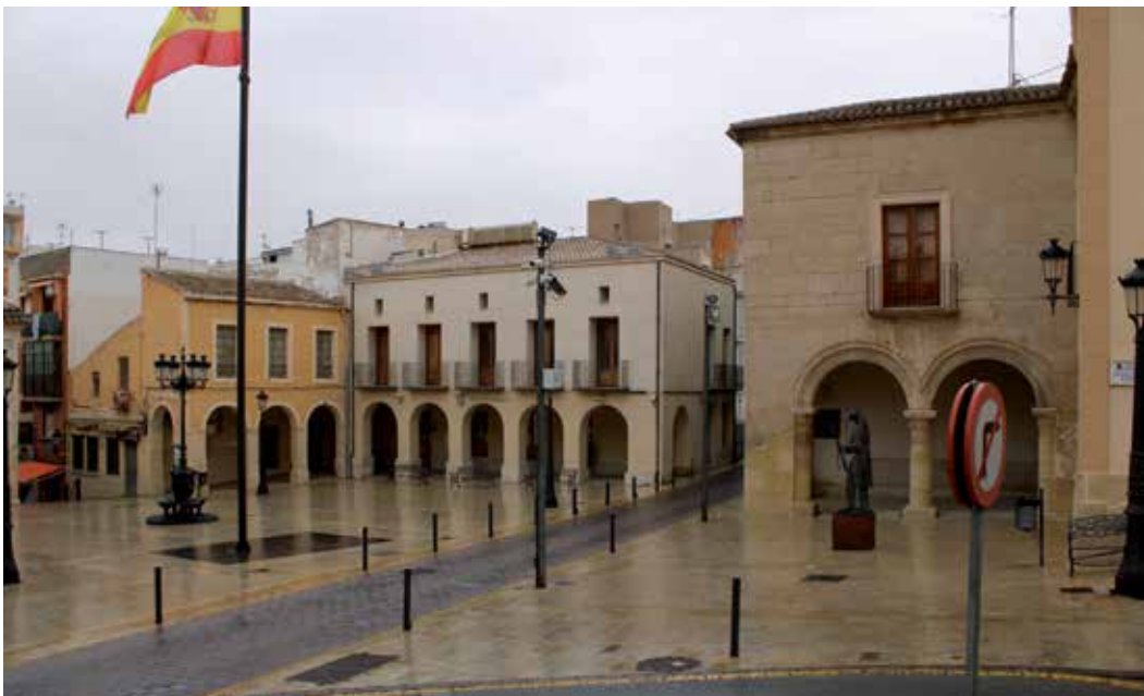
Fig. 2.- Yecla. La plaza Mayor . Vista de la galería porticada de la Casa de los Arcos y del antiguo alhorín o pósito. (Fotografía: Daniel Andrés Díaz, 2021).
