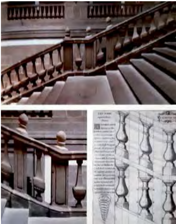
Balaustrada recta y oblicua de la escalera del Colegio de Minería en México, obra de Manuel Tolsá, basada en el tratado de Architectura civil recta y obliqua , (1678) de Juan Caramuel.
